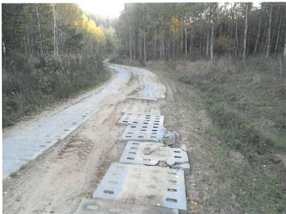
Rys. 2. Uszkodzenie nawierzchni płyt YOMB na łuku
