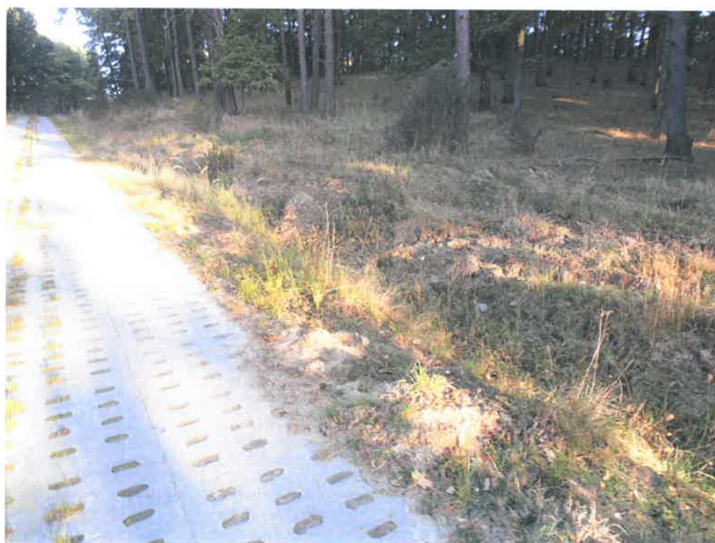
Rys. 4. Uszkodzenie poboczy
