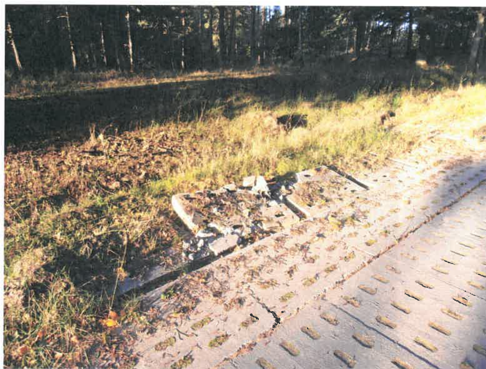
Rys. 3. Uszkodzenie nawierzchni płyt YOMB na mijance
